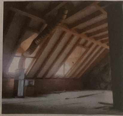
Im Dachstock hatte einst bereits Rolf Blättler mit einem Ausbau begonnen. Martina Eller möchte diese Arbeiten wieder aufnehmen. Hier sollen Mietwohnungen entstehen.
